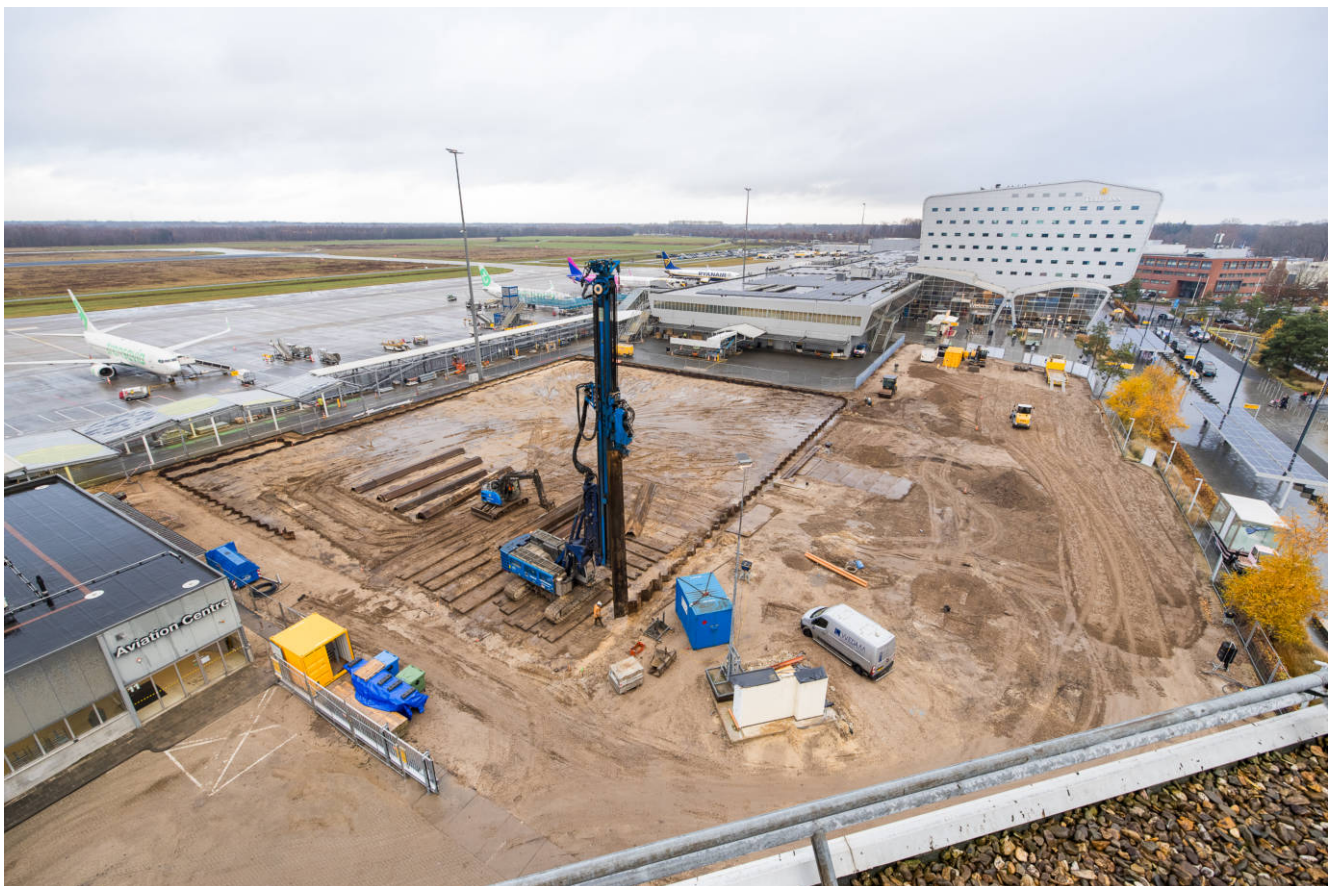
* Voorbereidingen voor de aanleg van de bagagekelder in het nieuwe gedeelte van de terminal
