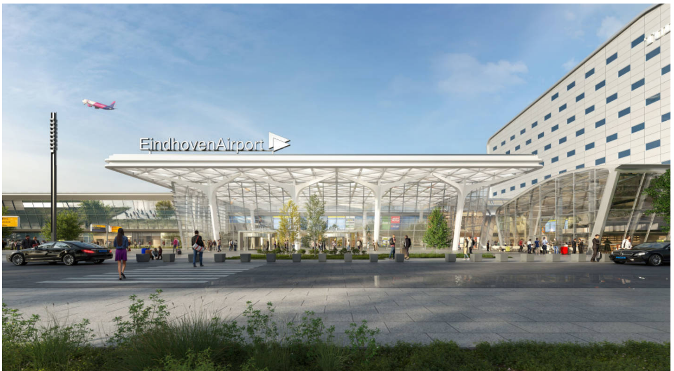
* Impressie van de terminaluitbreiding
